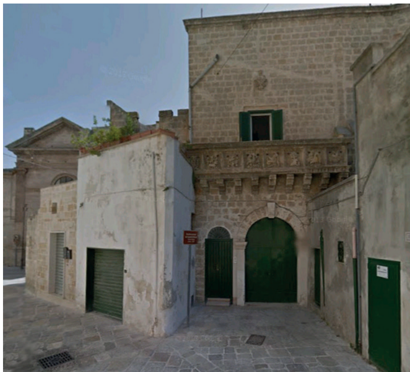
FIGURE 1. Palazzo Argentina, known as palazzo Leo , residence of the Musachi in Francavilla Fontana (Figure: «Palazzo Argentina», Terra dei Messapi , < http://terradeimessapi.it/palazzo-argentina >).
